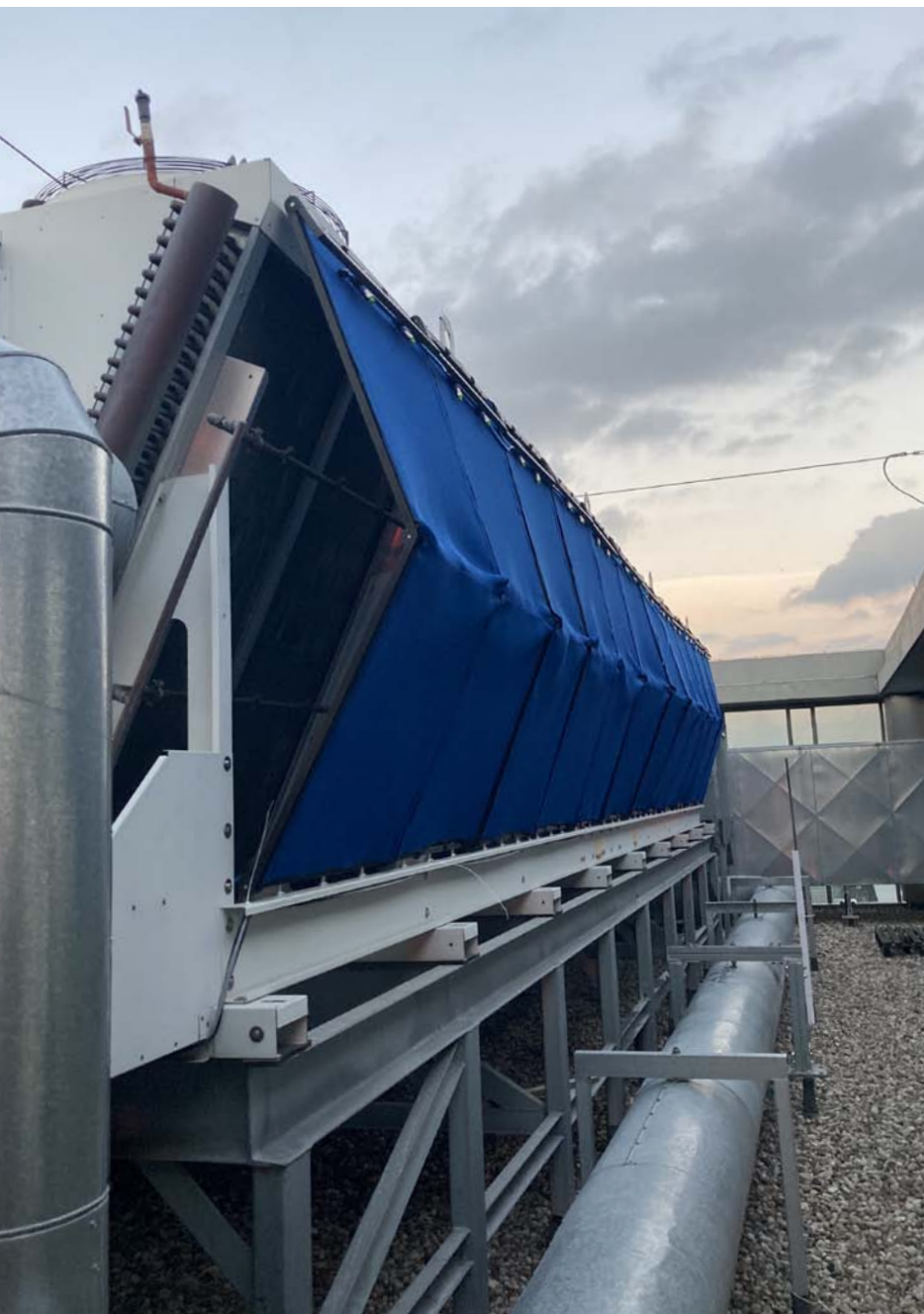
System chłodzenia adiabaticznego firmy Systemy SCA obniża zużycie energii przez urządzenia klimatyzacyjne i zwiększa ich wydajność
