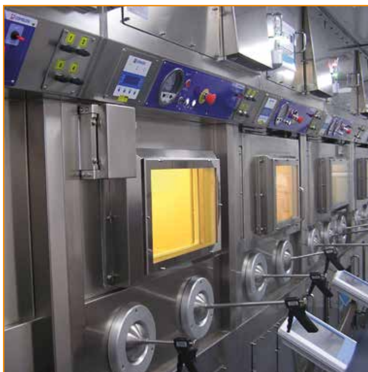
Linia technologiczna do wytwarzania obu prekursorów
