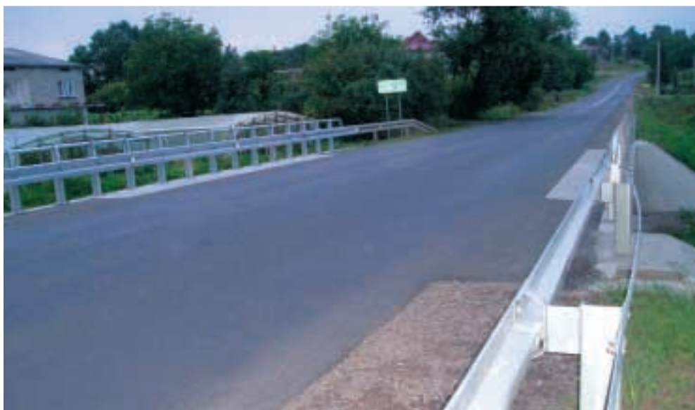
Fot. 31. Widok na wyremontowany most Photo 31. View of the repaired bridge
