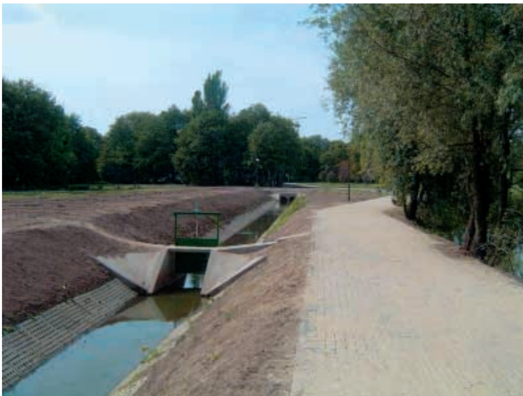
Fot. 46. Widok na wyremontowaną rzekę Photo 46. View of the renovated river bed
