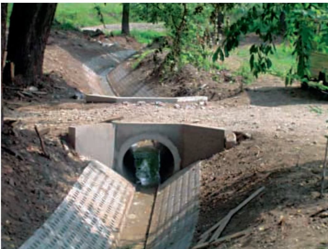
Fot. 20. Widok na przepust pod drogą lokalną Photo 20. View of culvert under a local road
