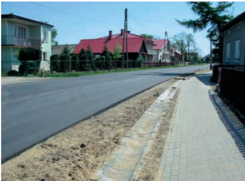
Fot. 26. Widok na odbudowaną drogę Photo 26. View of the reconstructed road
