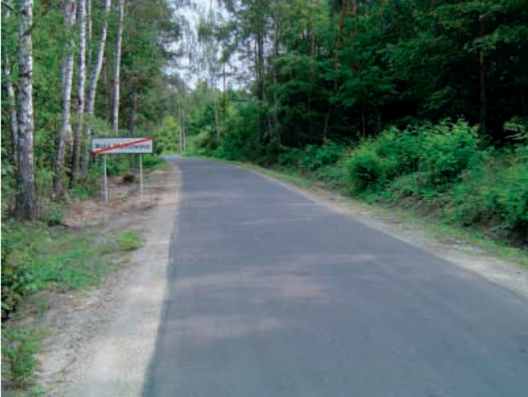
Fot. 44. Widok na wyremontowaną drogę Photo 44. View of the repaired road
