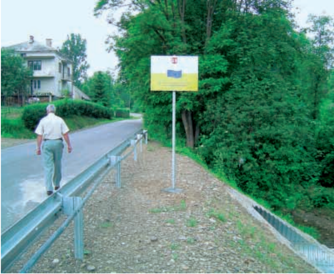
Fot. 15. Widok na zabezpieczoną skarpe i wyremontowaną drogę Photo 15. View of the protected and modernized road bank
