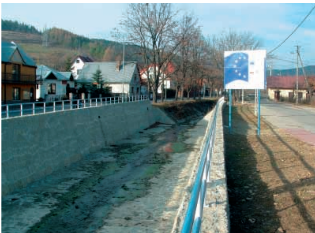
Fot. 9. Żłób koryta potoku po rekonstrukcji Photo 9. Stream bed after the reconstruction
