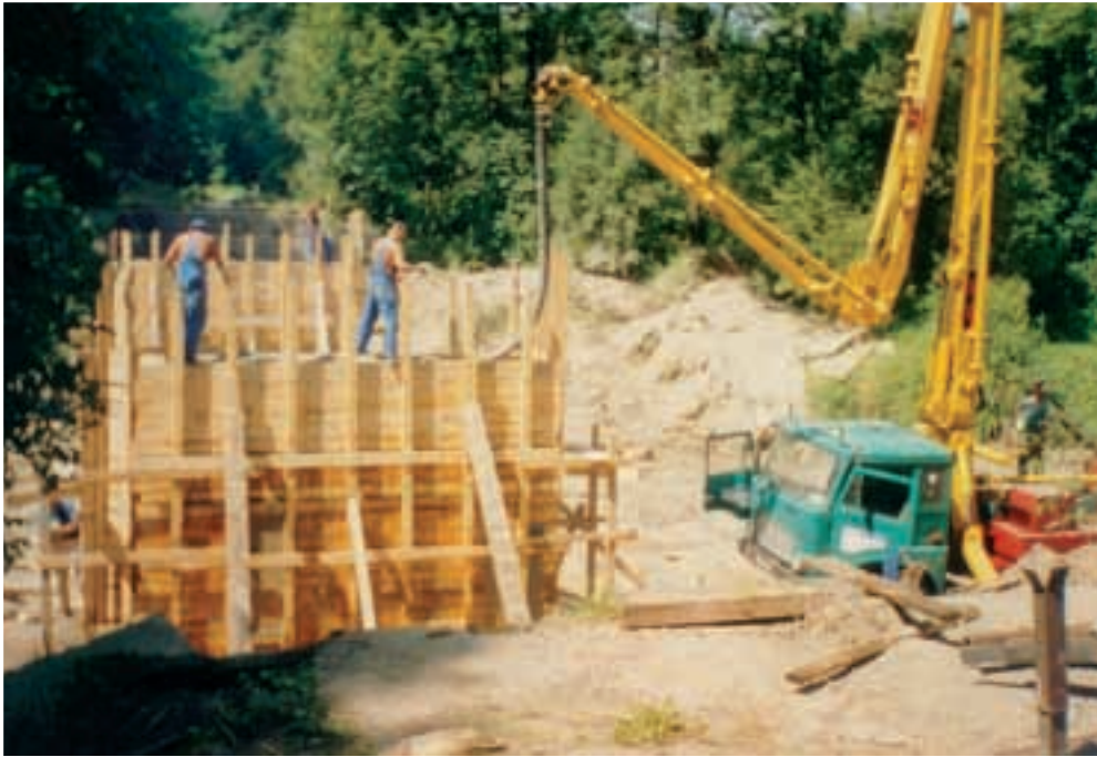
Fot. 2. Prace przy odbudowie mostu Photo 2. Bridge reconstruction works
