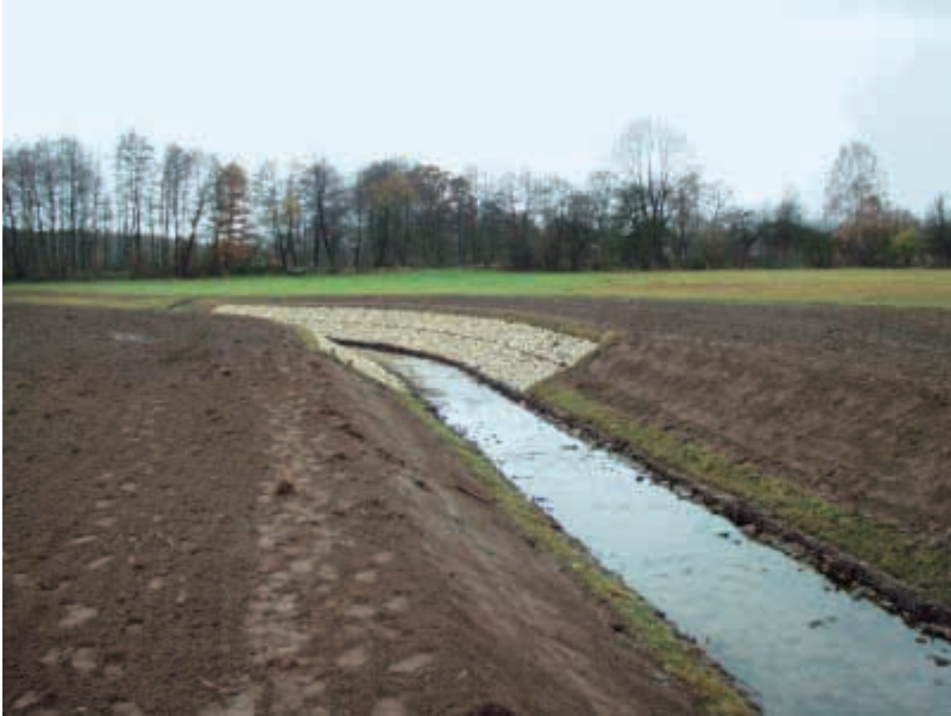
Fot. 49. Odbudowane zabezpieczenia przeciwpowodziowe wzdłuż rzeki Photo 49. Reconstructed flood protection system long the river
