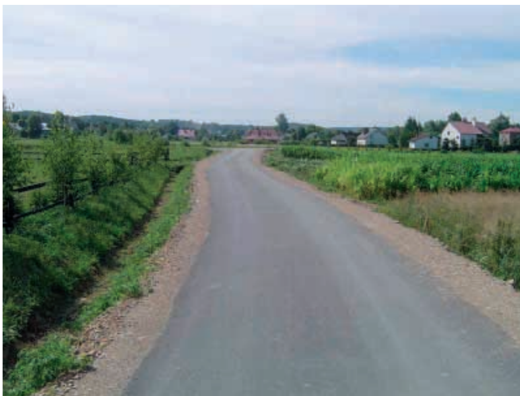
Fot. 30. Widok na odbudowaną drogę Photo 30. View of the reconstructed road
