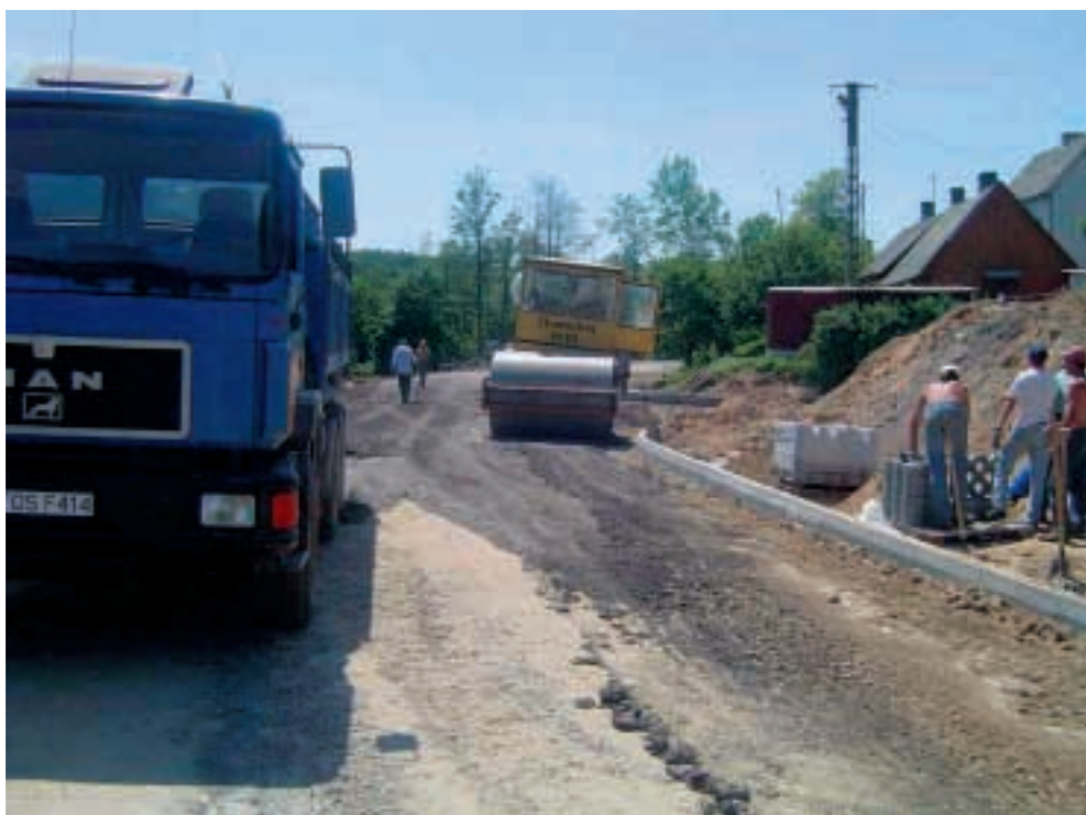
Fot. 36. Widok na prace przy rekonstrukcji drogi Photo 36. View of road reconstruction works
