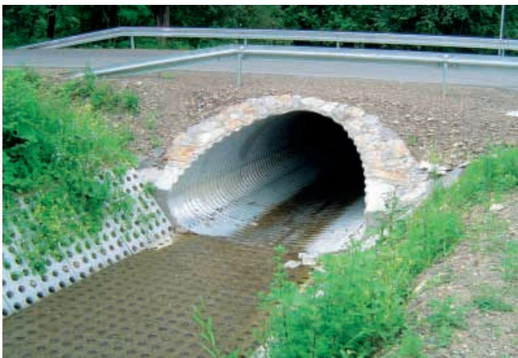
Fot. 14. Widok na przepust i korpus odbudowanej drogi Photo 14. View of the culvert and the body of the reconstructed road
