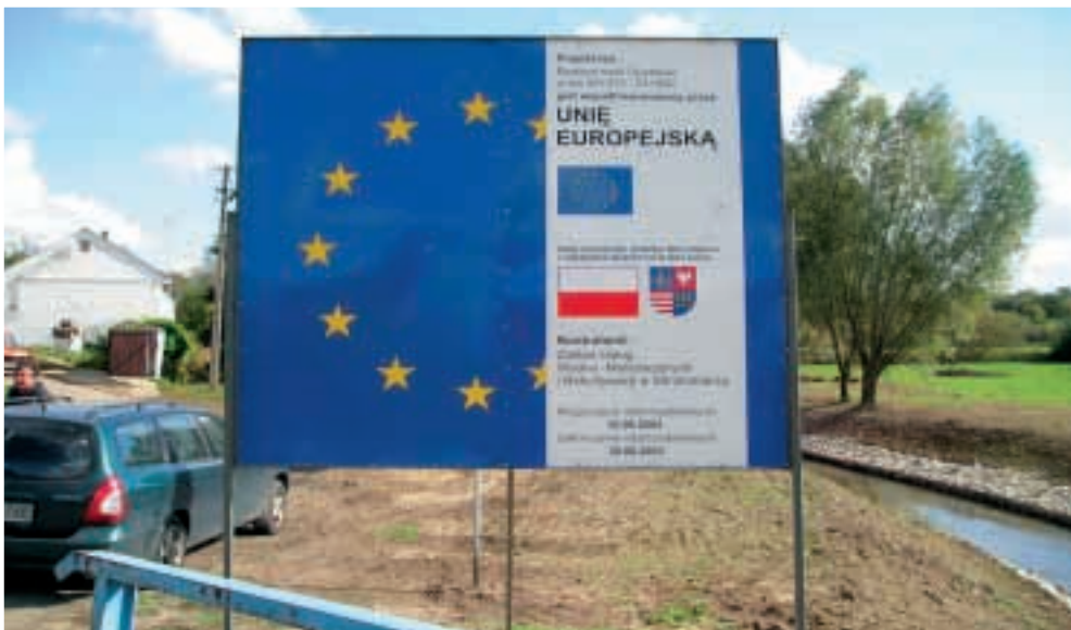
Fot. 33. Widok na wyregulowaną rzekę Photo 33. View of the regulated river
