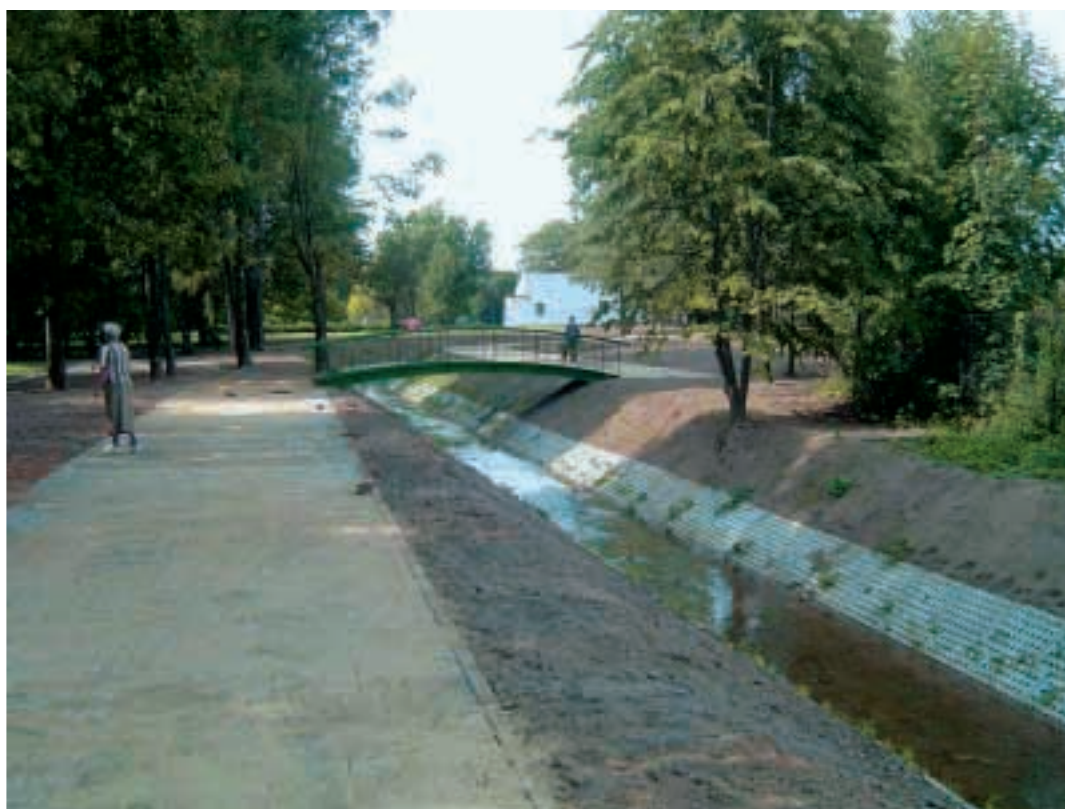
Fot. 47. Efekt końcowy prac naprawczych Photo 47. The final result of the repair works
