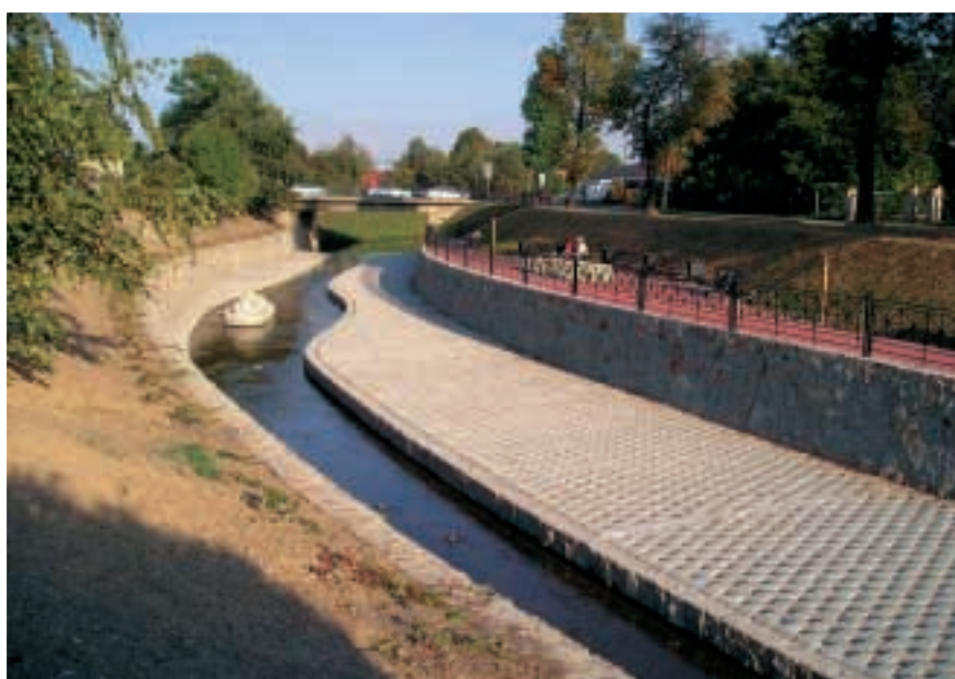
Fot. 4. Widok na zabezpieczone koryto i tereny przybrzeżne Photo 4. View of the protected bed and areas on the banks
