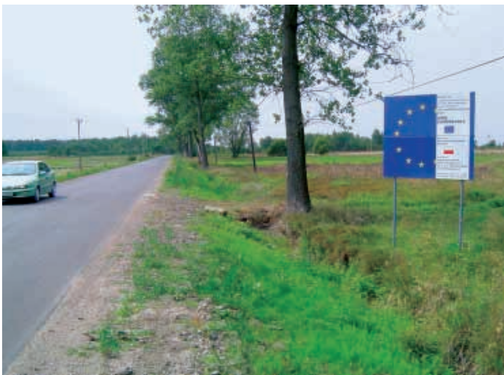
Fot. 43. Odbudowany odcinek drogi powiatowej Photo 43. Reconstruction of the section of the poviast road
