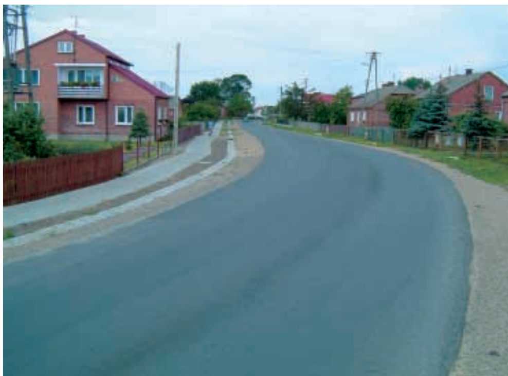
Fot. 27. Widok na odbudowaną drogę Photo 27. View of the reconstructed road
