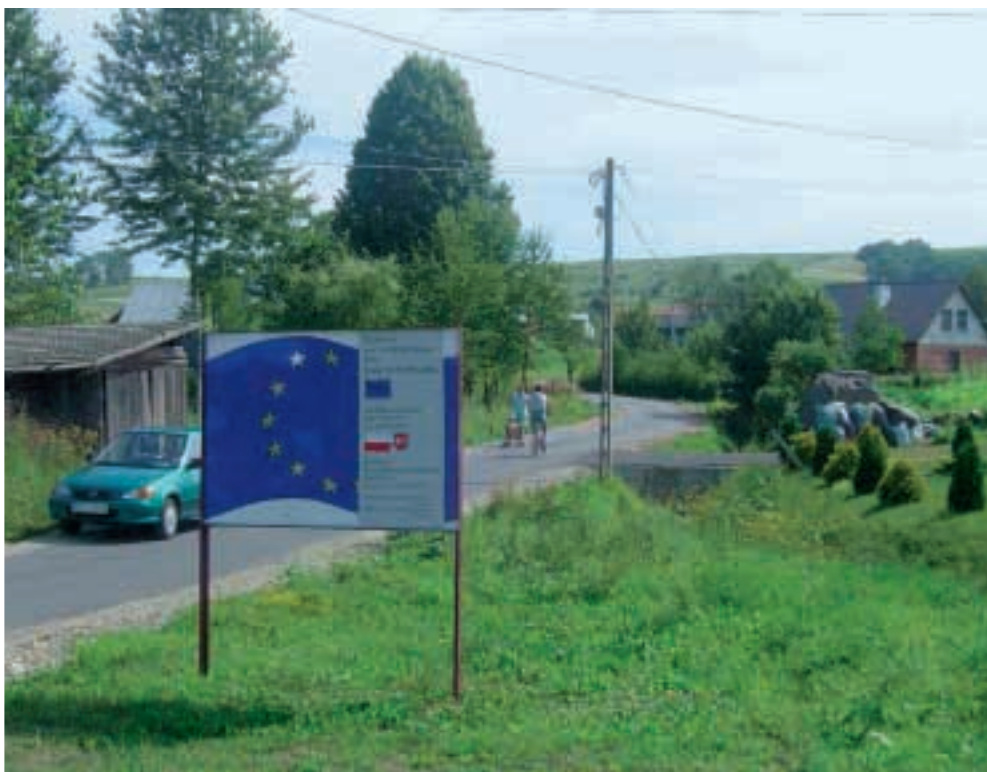
Fot. 28. Widok na wyremontowaną drogę Photo 28. View of the reconstructed road
