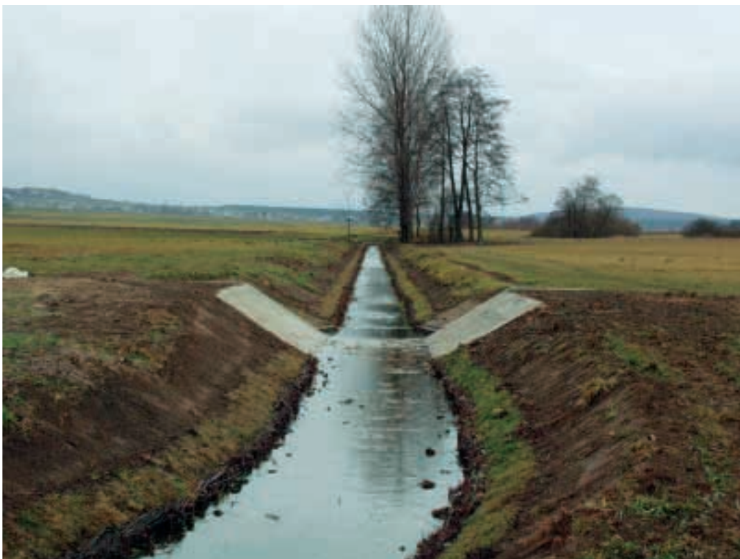
Fot. 50. Efekt końcowy prac remontowych Photo 50. The final result of the reconstruction works
