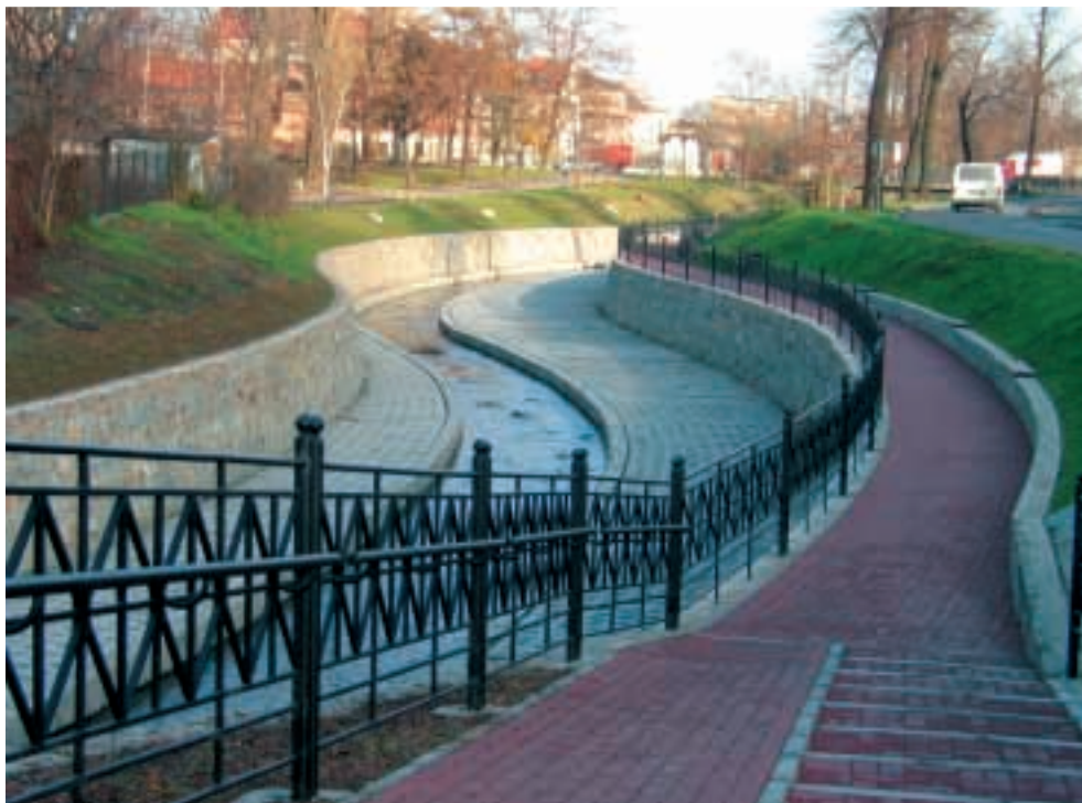
Fot. 5. Widok na zabezpieczone koryto i tereny przybrzeżne Photo 5. View of the protected bed and areas on the banks
