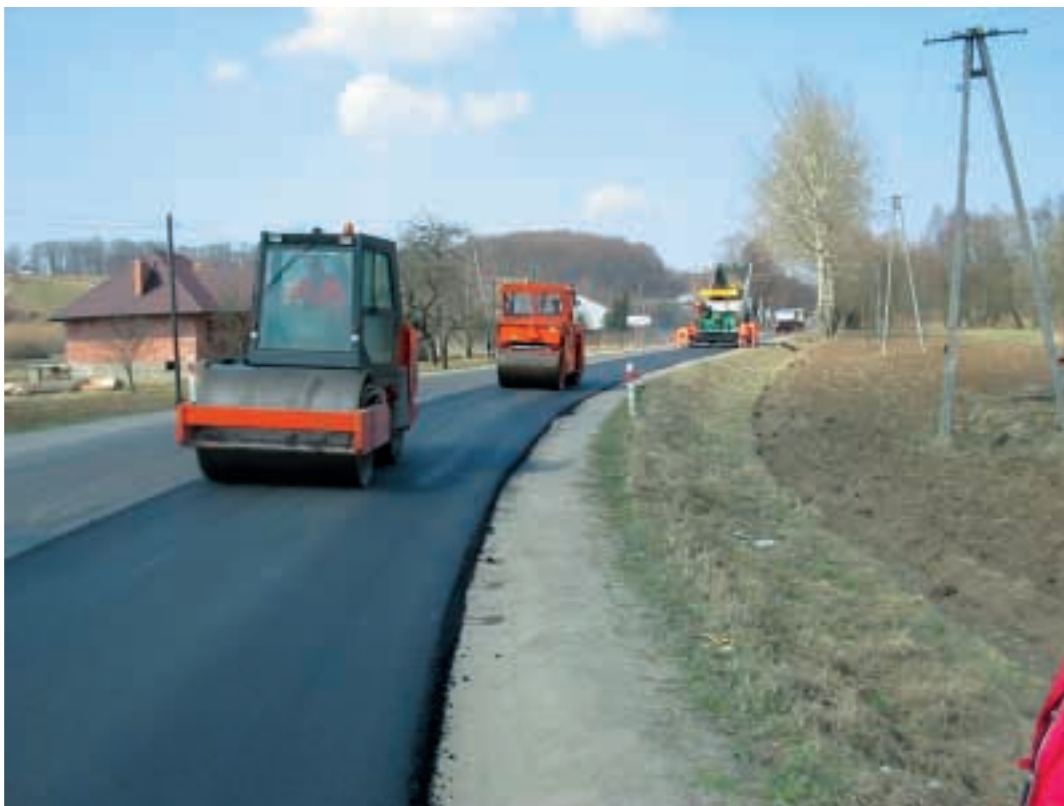
Fot. 41. Prace przy odbudowie drogi Photo 41. Work on reconstruction of the road
