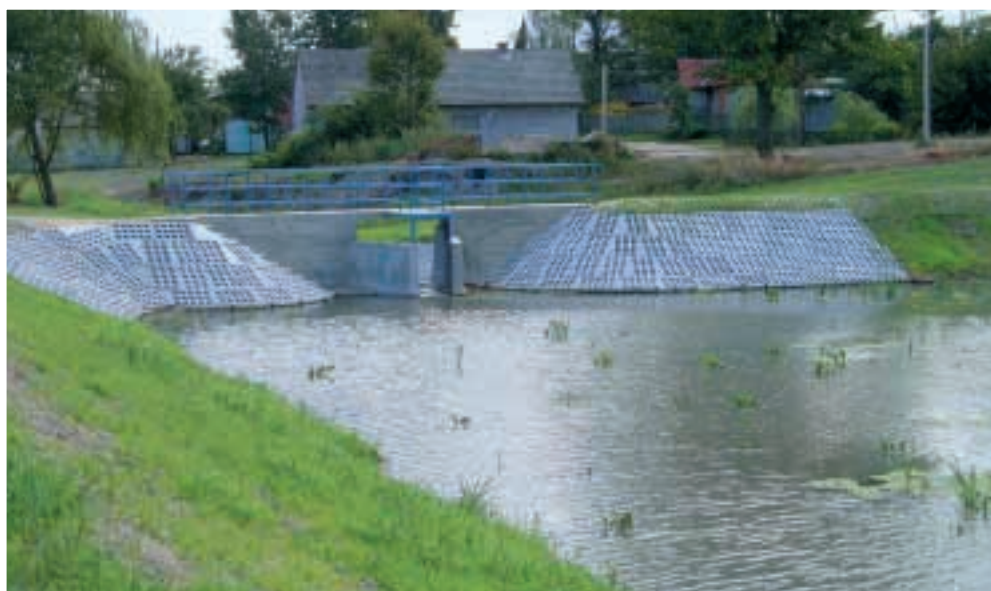
Fot. 23. Widok na udrożnione i zabezpieczone koryto potoku Photo 23. View of cleared and protected stream bed
