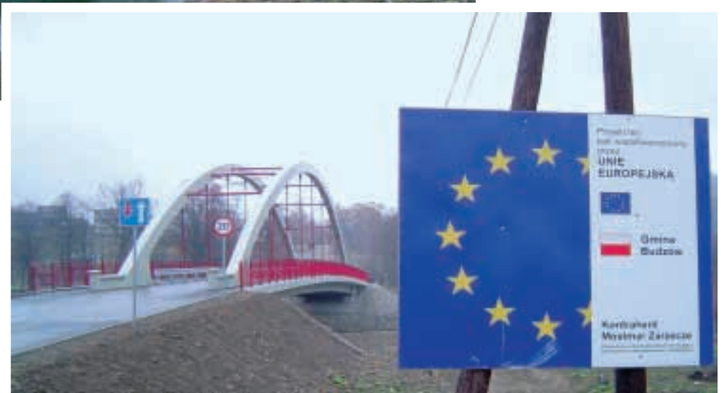
Fot. 12, 13. Widok na odbudowany most w Budzowie Photo 12, 13. View of the reconstructed bridge in Budzów
