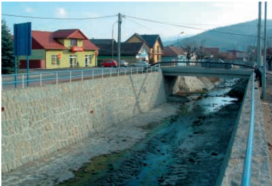
Fot. 8. Żłób koryta potoku po rekonstrukcji Photo 8. Stream bed after the reconstruction
