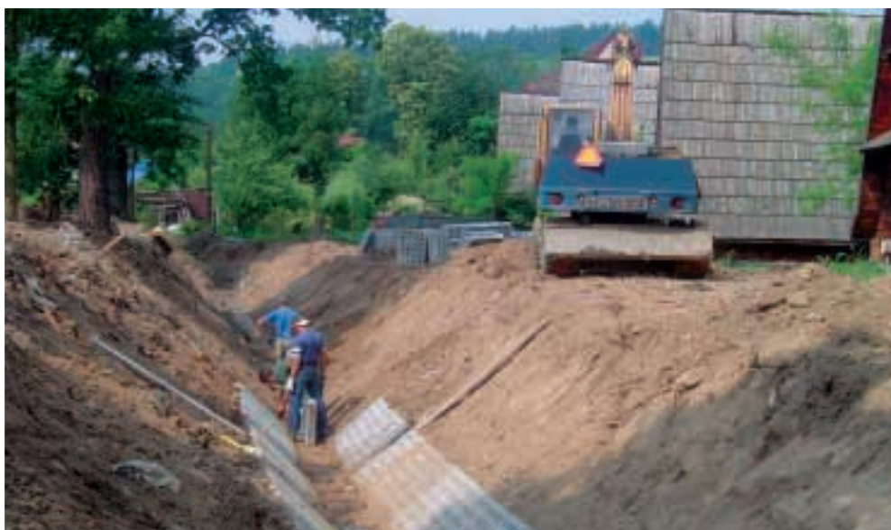
Fot. 18. Prace przy odbudowie rowów melioracyjnych Photo 18. Work on reconstruction of drainage ditches
