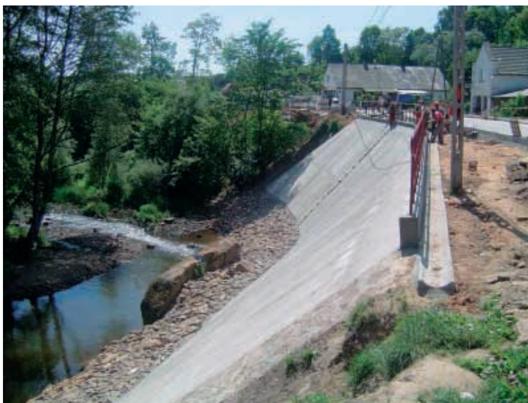
Fot. 38. Widok na zabezpieczoną skarpe Photo 38. View of protected bank
