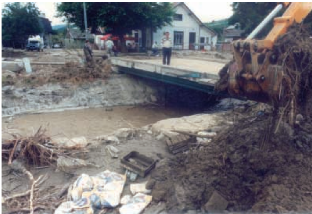
Fot. 7. Żłób koryta potoku przed rekonstrukcją Photo 7. Stream bed before the reconstruction
