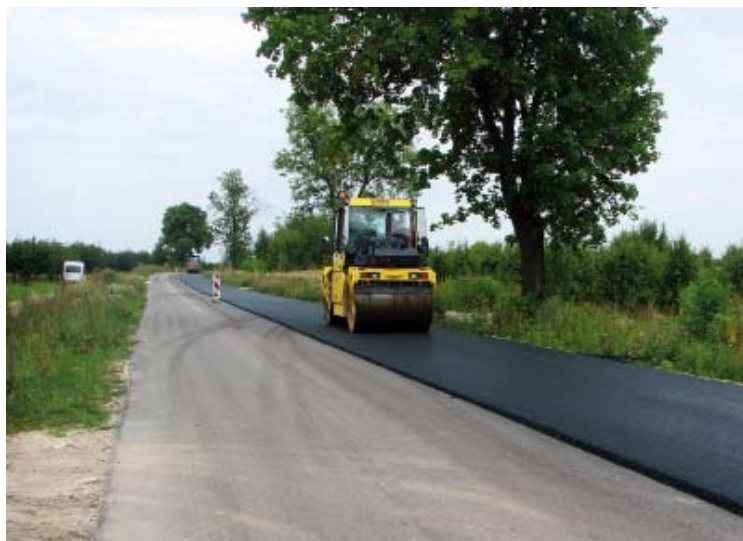
Przebudowa drogi Chmielnik-Staszów
