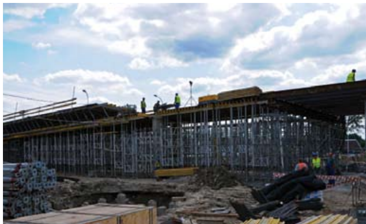
Budowa Trasy Generalskiej w Białymstoku
